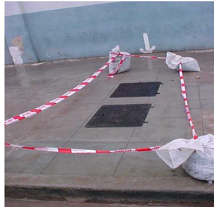
Construcción de cámara de medición y refacción de vereda
