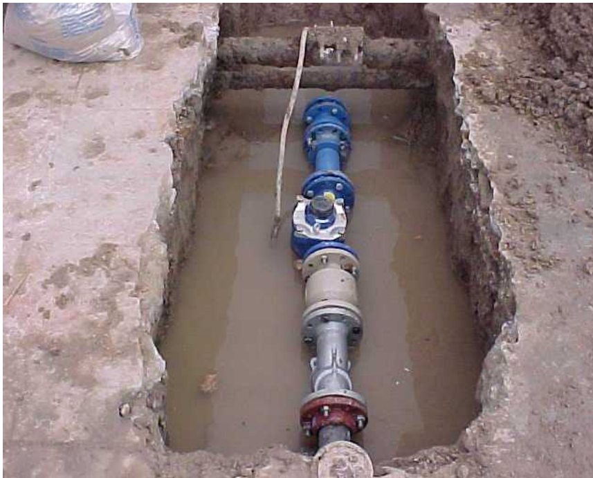
Apertura en vereda y colocación de elementos de normalización
